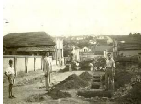
Construção da rede de esgoto, na década de 1950, pelo então prefeito Geraldo Guimarães.
