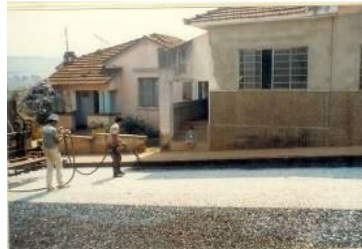
Pavimentação da Rua Cel. Federico Franco, na década de 1980
