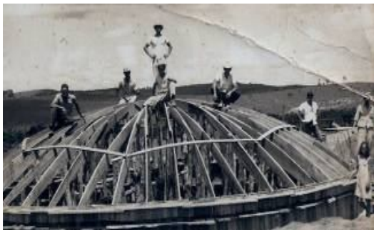
Construção da caixa d'água comunitária, na década de 1950
